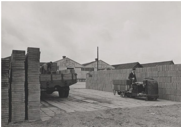
Nanengat eind jaren 60 - het opslagterrein van Jan Lingen beton
