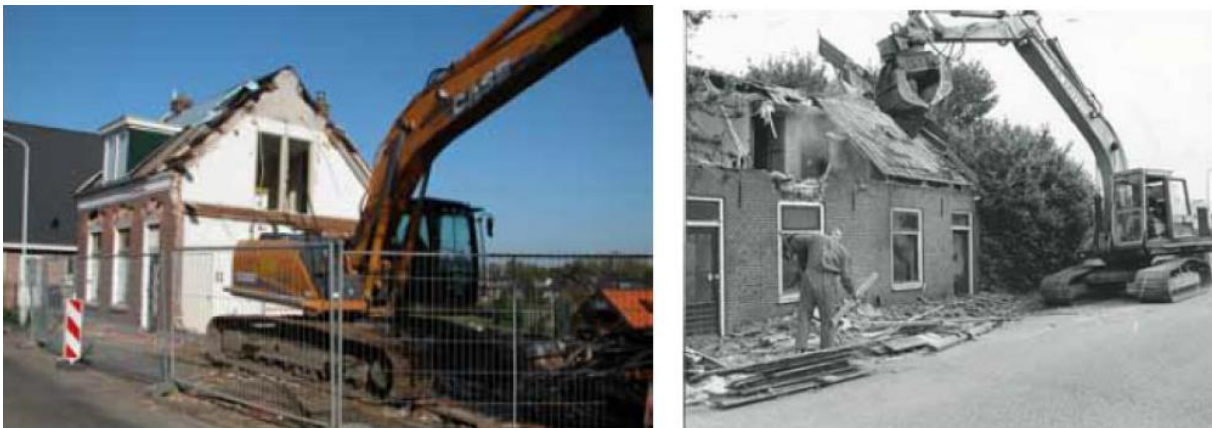
Afbeelding 6: Sloop van bebouwing ten behoeve van dijkverzwaring (bron: Dijkvisie Papendrecht)
