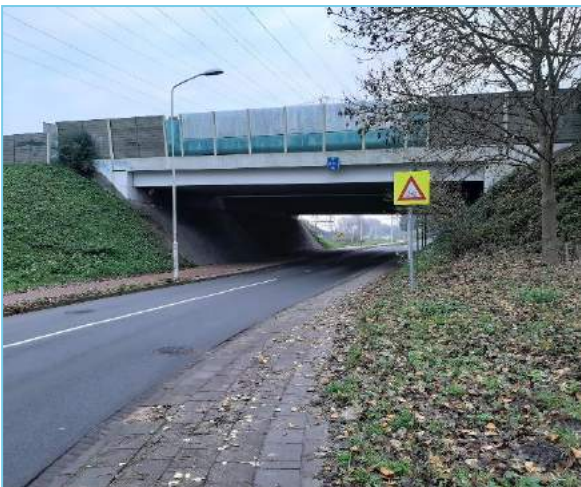
Figuur 20: Beperkt oprij- en stopzicht westzijde oversteekplaats.
