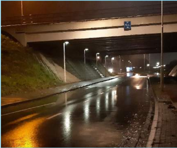
Figuur 16: Afwijkende verlichtingskleur onderdoorgang N3
