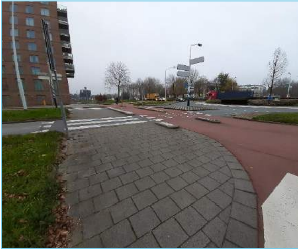
Figuur 41: Grote oversteeklengte over zebra- en fietspad.
