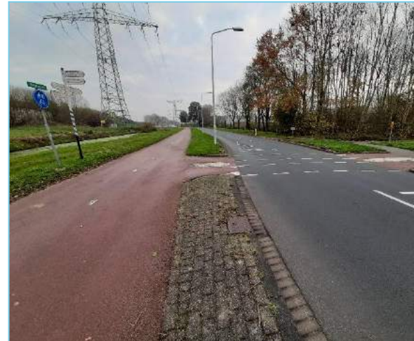
Figuur 19: Beperkte opstelruimte tussen fietspad en rijbaan.
