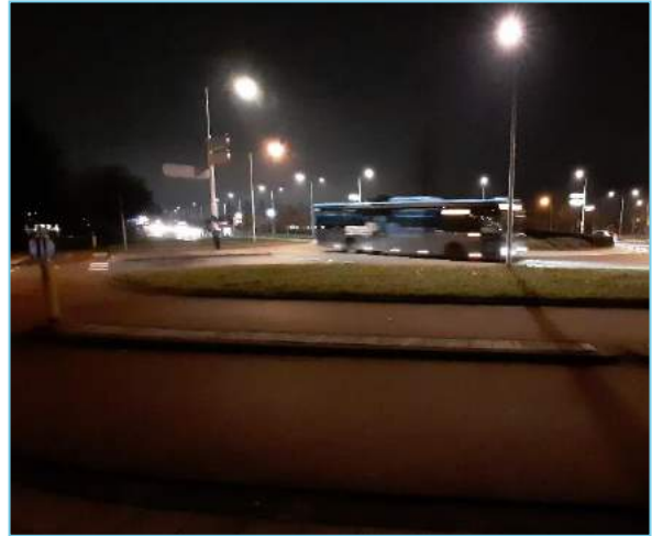
Figuur 36: Beperkte verlichting fietspad tussen rotondetakken.
