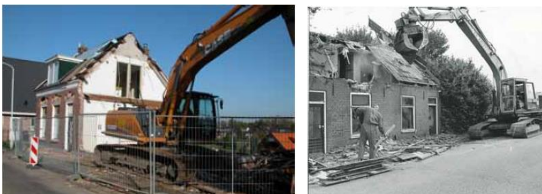
Figuur 2.4 Sloop van bebouwing ten behoeve van dijkverzwaring (bron: Dijkvisie Papendrecht)
