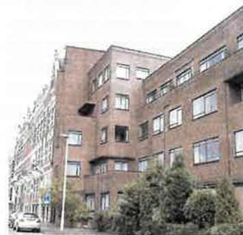
Woongebouw aan Westzeedijk, Rotterdam Gezoneerde gevelopbouw Architect: van Lohuizen
