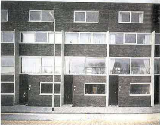
Ensemble D stadswoningen van vier lagen Prinsenland, Rotterdam Architect: van Sambeek & van Veen
