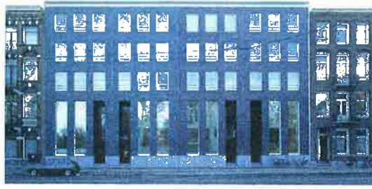
Oosterpark, Amsterdam Combinatie van stadswoningen en appartementen tot één architectonisch beeld. architect: van Sambeek en van Veen
