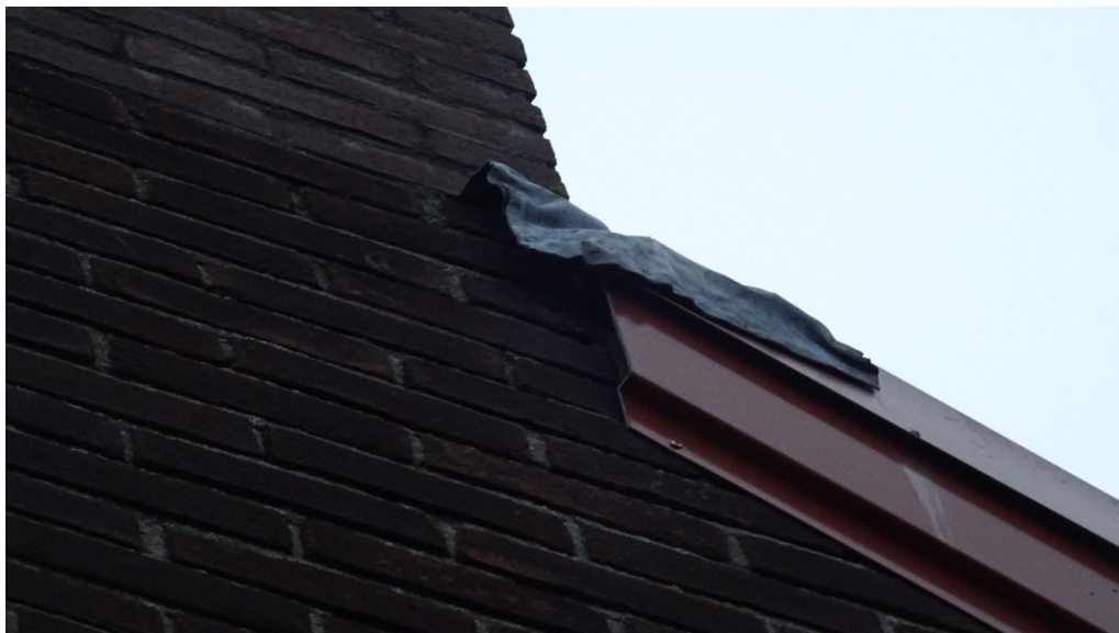
Wijkende loodslab langs een zijgevel. Foto: K.J. van Veen | Ecoresult B.V.
