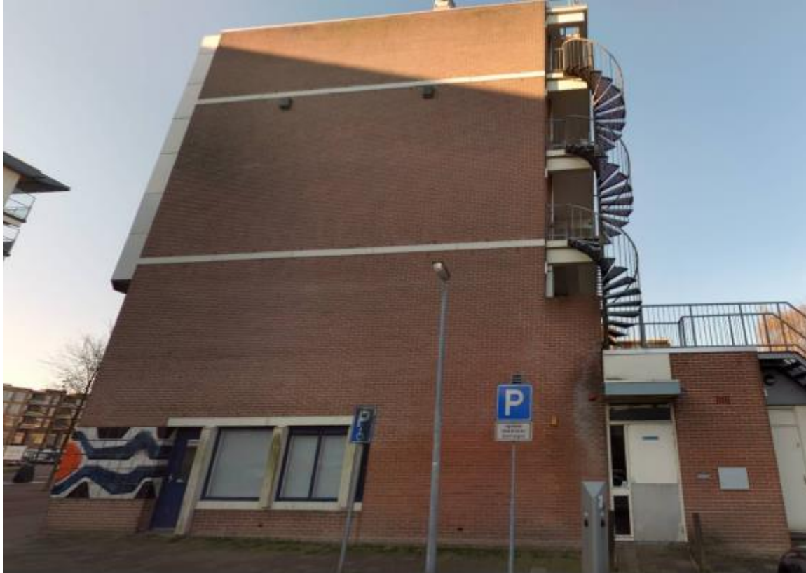
Figuur 4.2: Reeds opgehangen vleermuiskasten aan de noordgevel van complex Schoolstraat
