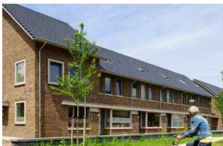
Schakelen van woningen door o.a. doorlopende erkers
