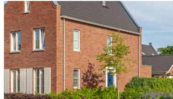
Entree 'om de hoek', meerdere gevelopeningen
