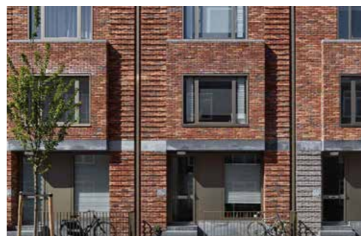
Uitkragende erkers en doorlopende betonrand
