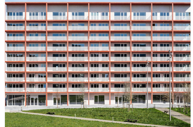
Referentie: gerenoveerd bouwblok met nieuwe gevel
