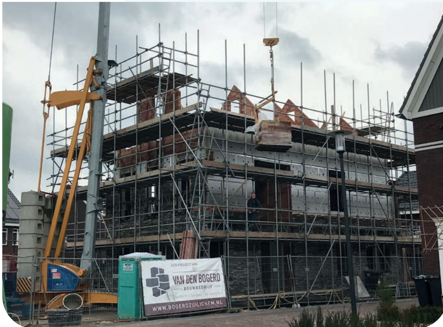
De laatste woning in aanbouw.
