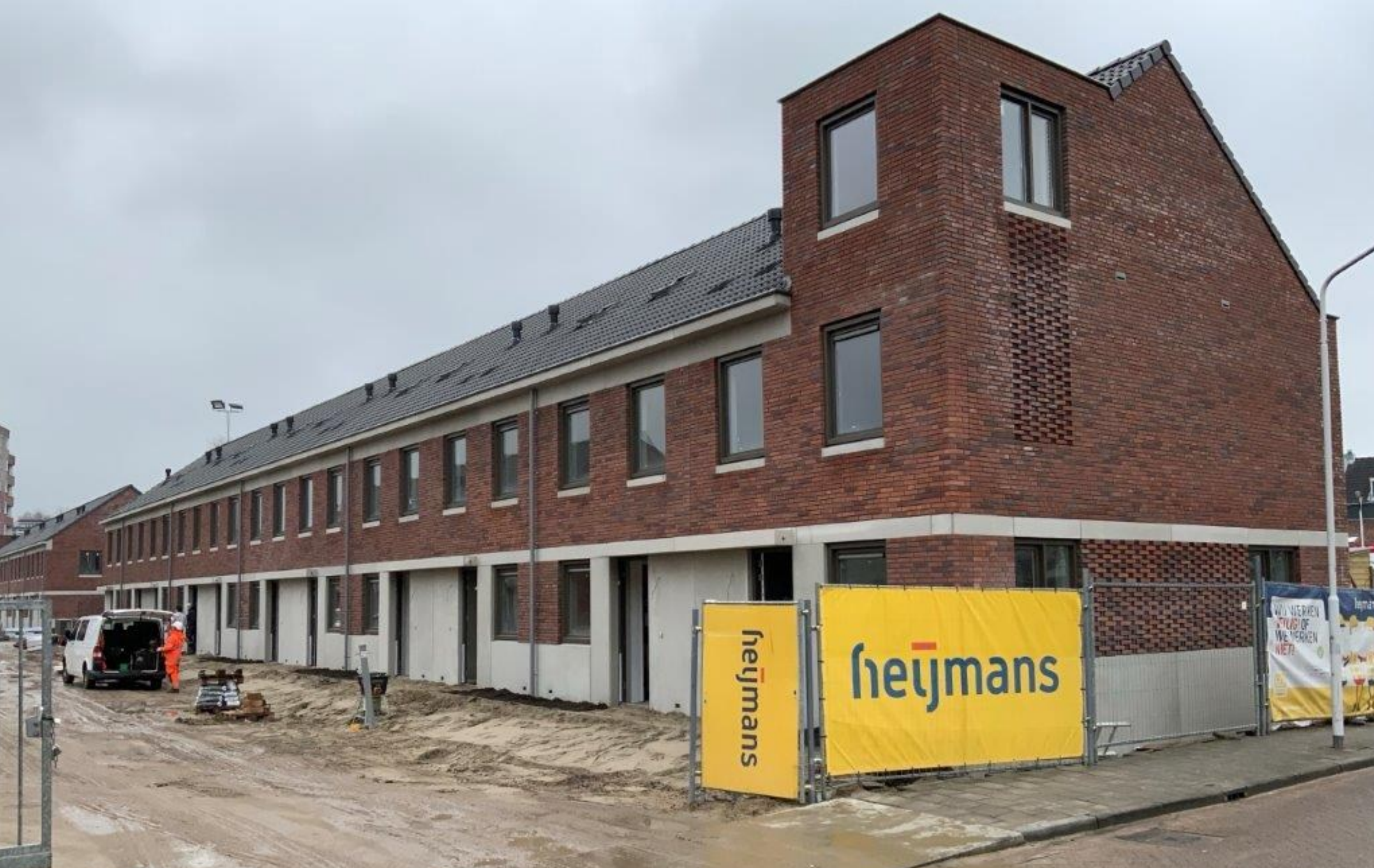
Afbeelding: nieuwbouw project Kraaihoek Zuid, eerste fase. Bouw gestart in 2024
