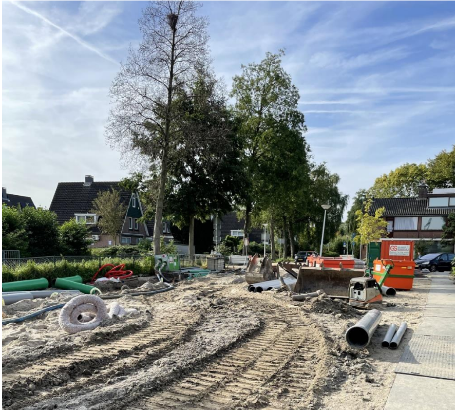
Vervanging riolering Noordersingel
