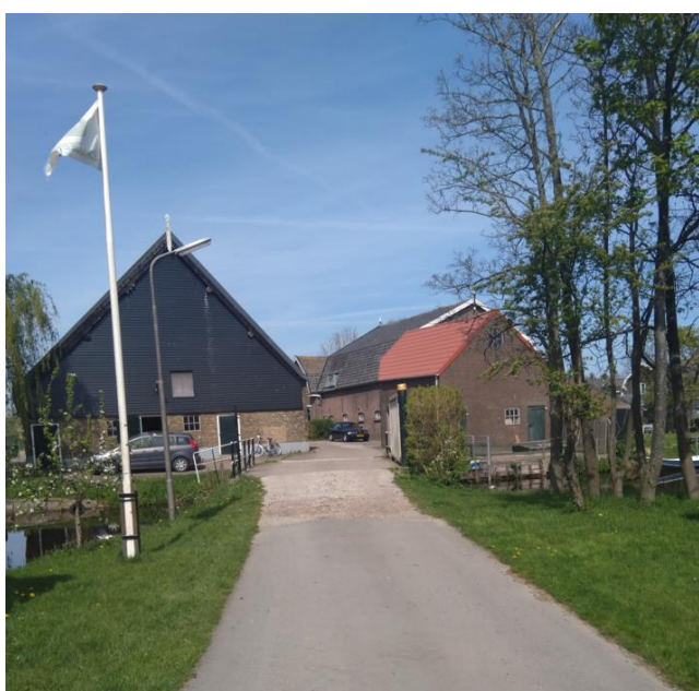
Zicht vanaf de Westeinde, de inrit naar de locatie richting de beoogde locatie van de kleine windmolen
