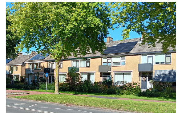
Aanliggende bebouwing buurt Westpolder
