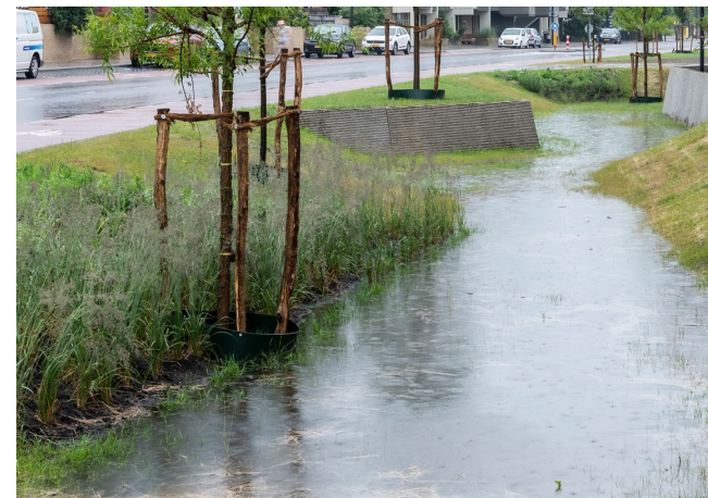
Kernwaarde 4 en 5. Toepassen van waterinfiltratie en waterbuffers
