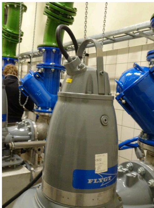
Nieuwe pompen hoofdgemaal Vondelpark 1
