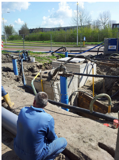
Vervanging gemaal Bosweg
