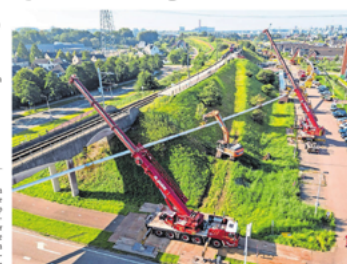
De aanleg van het warmtenet bij Sluisdrecht.
