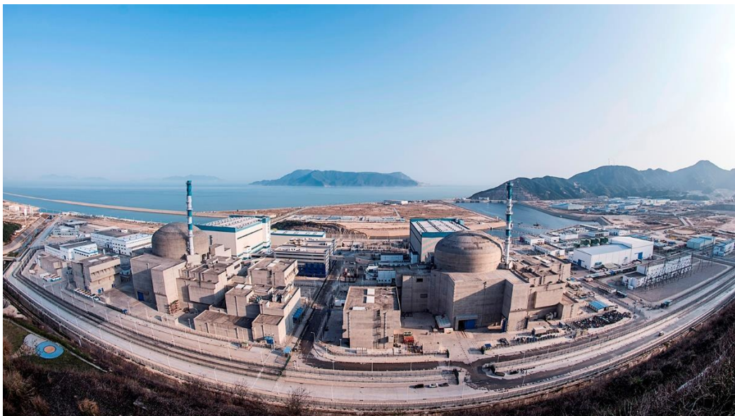
Twee EPR Nuclear Power Plants in Guangdong, China Bouwtijd 9 jaar – kosten 8 miljard dollar per unit.
