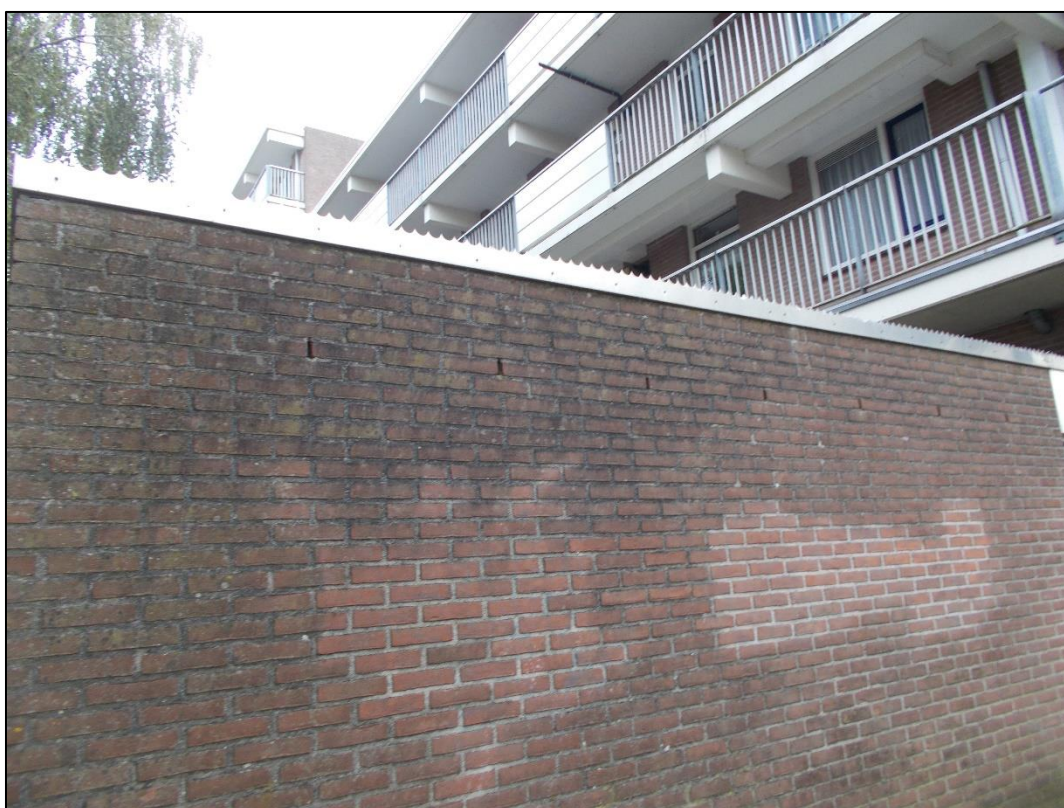
Foto 7: Vleermuisgeschiktheid van het gebouw.
