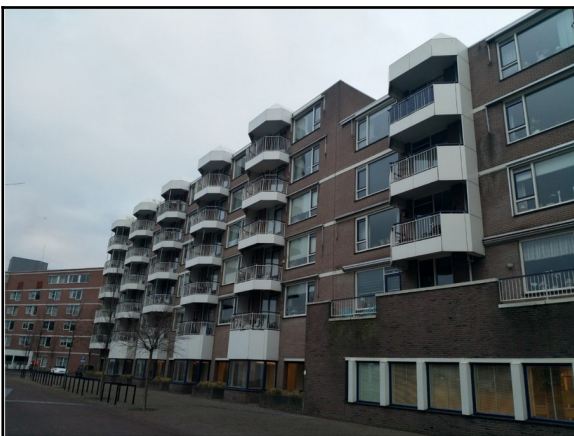
Afbeelding 2: Impressie van de oostgevel van het appartementencomplex. Foto: C.E. Bakker | Ecoresult B.V.
